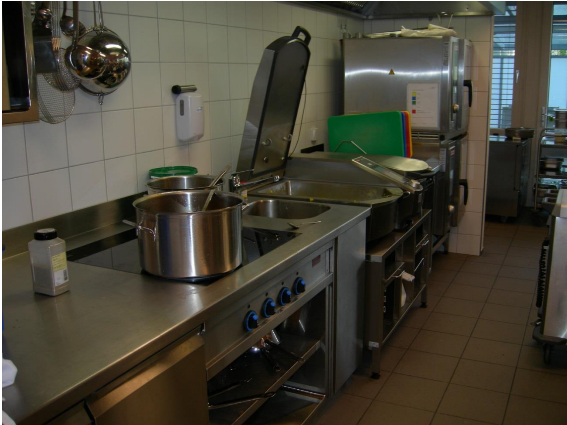
Der Blick geht auf die Aufbereitung und Produktionslinie
